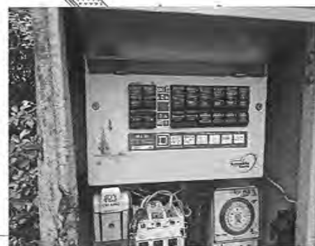
รื้อตู้ไฟฟ้าเดิมออก และติดตั้งตู้ควบคุมไฟฟ้าใหม่
