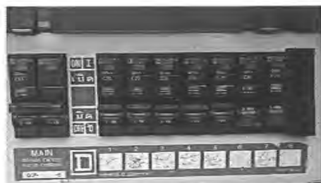
รื้อตู้ไฟฟ้าเดิมออกและติดตั้งควบคุมตู้ไฟฟ้าใหม่แทนคือ ตู้ CU2
