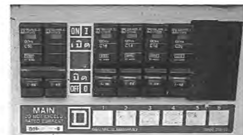
รื้อตู้ไฟฟ้าเดิมออกและติดตั้งควบคุมตู้ไฟฟ้าใหม่แทนคือ ตู้ CU3
