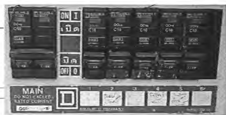
รื้อตู้ไฟฟ้าเดิมออกและติดตั้งควบคุมตู้ไฟฟ้าใหม่แทนคือ ตู้ CU1
